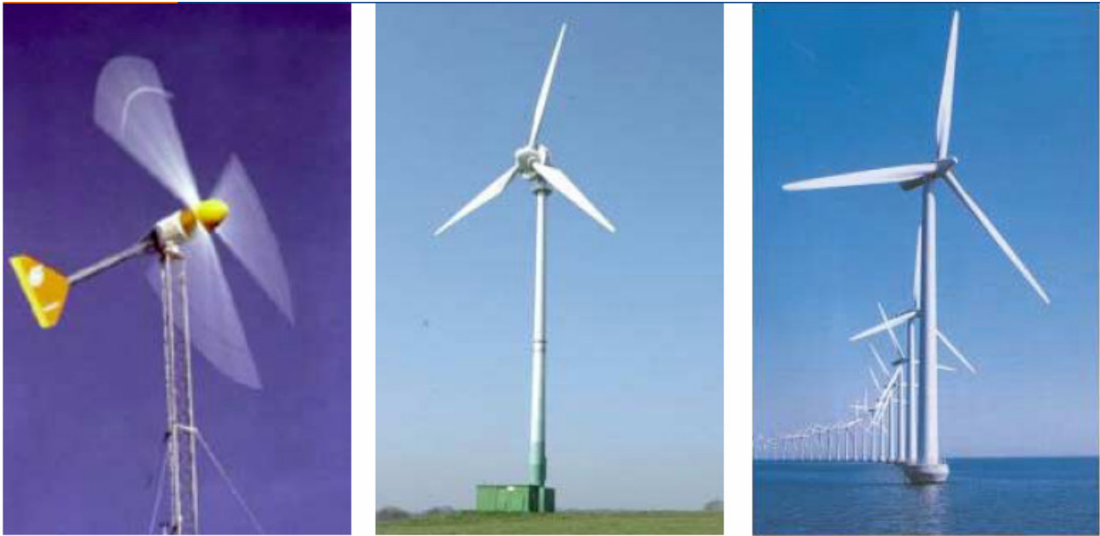
Figura 2.7: Exemplos de aerogeradores (da esquerda para a direita: pequeno, médio e grande).
