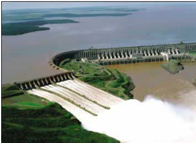
Figura 1.1: Vista panorâmica da Usina Hidrelétrica de Itaipu Binacional. Fonte: ITAIPU (2001).
