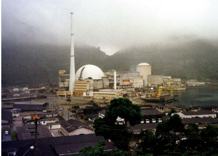
Figura 1.2: Central Nuclear Almirante Álvaro Alberto, localizada na região de Angra dos Reis (RJ).
