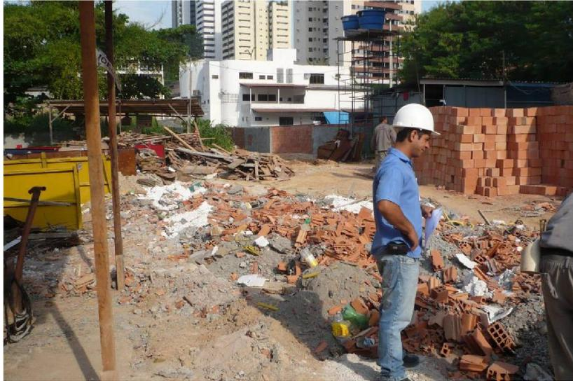
Figura 13 – Resíduo da obra A no canteiro com perdas de tijolos
