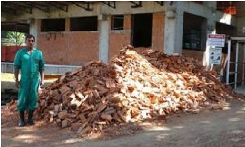
Figura 12 – Sobras de bloco cerâmico da obra F
