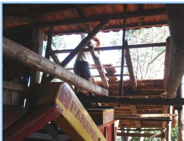
Figura 20 – Agricultor ampliando telhado de galpão da propriedade agrícola com madeira nativa no município de Anchieta.
