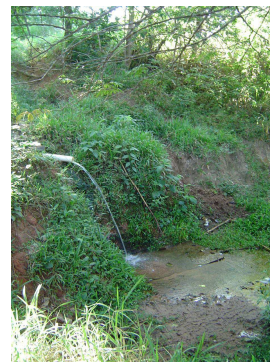
Figura 3: Liberação de esgoto
