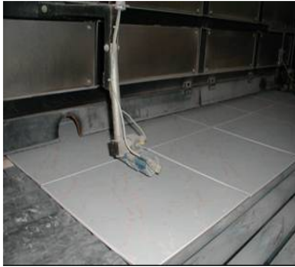
Figura 3.5 – Entrada dos revestimentos cerâmicos no interior do forno.
