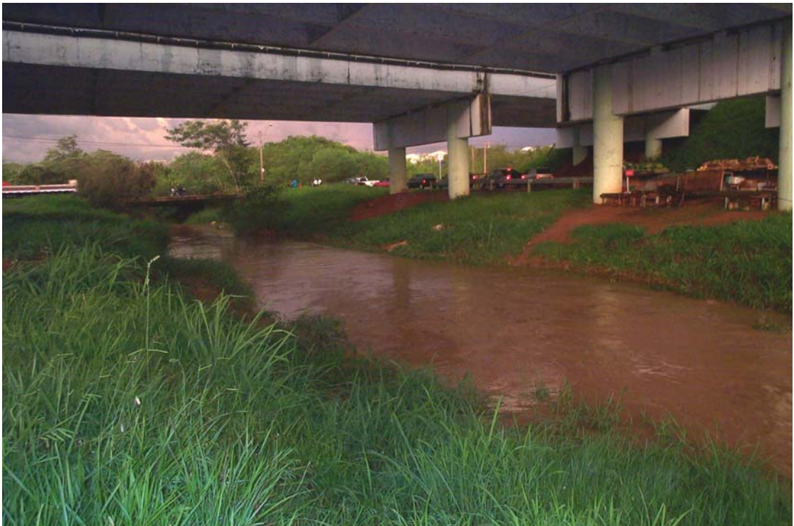
Figura 3. Vista geral do trecho coletado no córrego do Macaco no município de São José do Rio Preto, SP após chuva ocorrida na área de drenagem da micro-bacia.
