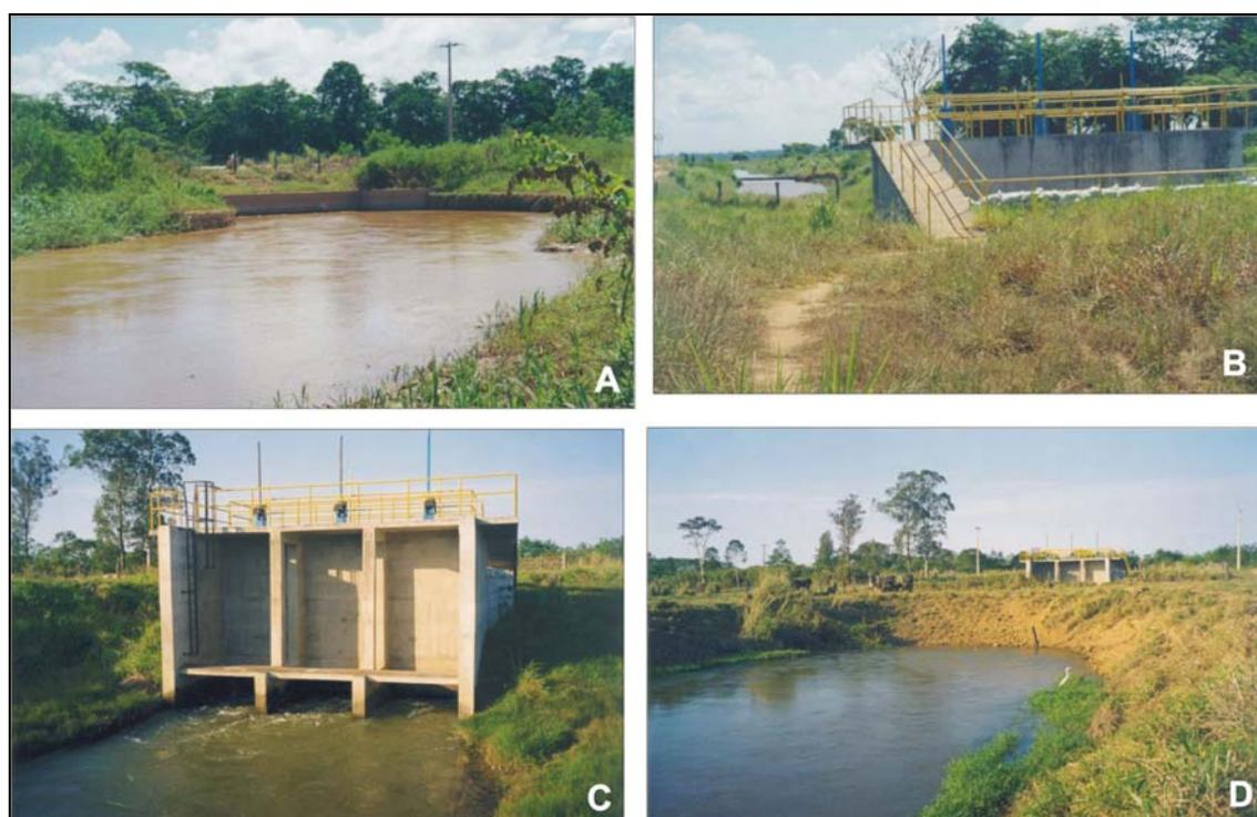
Figura 69. Início do canal, Fazenda Goianazes: primeira obra de seccionamento na estrutura do Canal Caboclo Bernardo em concreto armado com stop-logs (estruturas com finalidade de interromper, se necessário, o curso d'água). Veja Quadro 27 para maiores detalhes.
