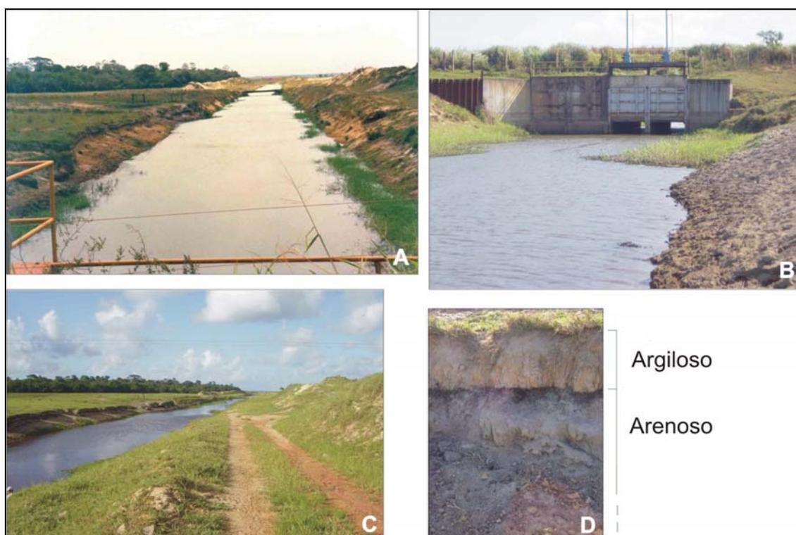
Figura 70. Travessia da estrada municipal Bebedouro-Regência: galerias com concreto pré-moldado com stop-logs. Veja Quadro 28.
