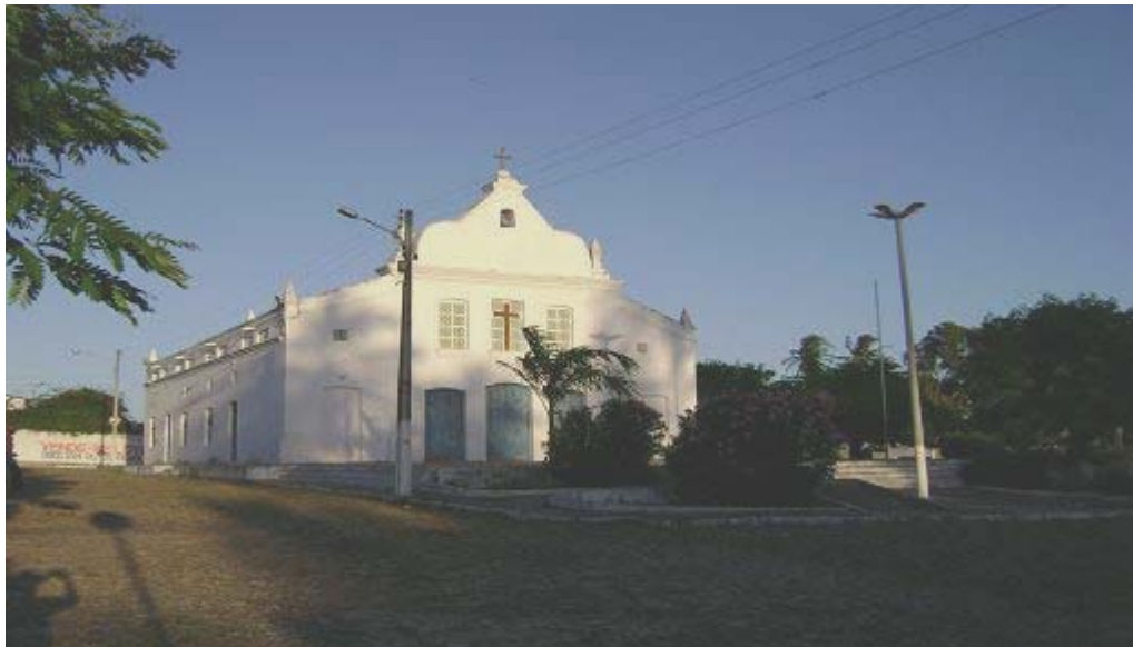
Figura 1: Igreja Matriz Nossa Senhora do Livramento Fonte: Iandra Nascimento, 2007
