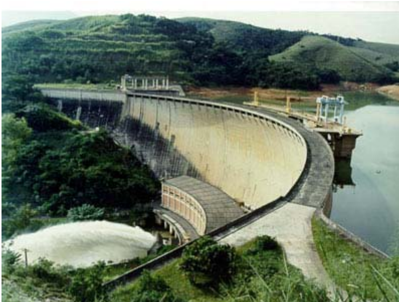
Figura 4.1 Arranjo geral da barragem Funil do tipo abóbada de dupla curvatura.
