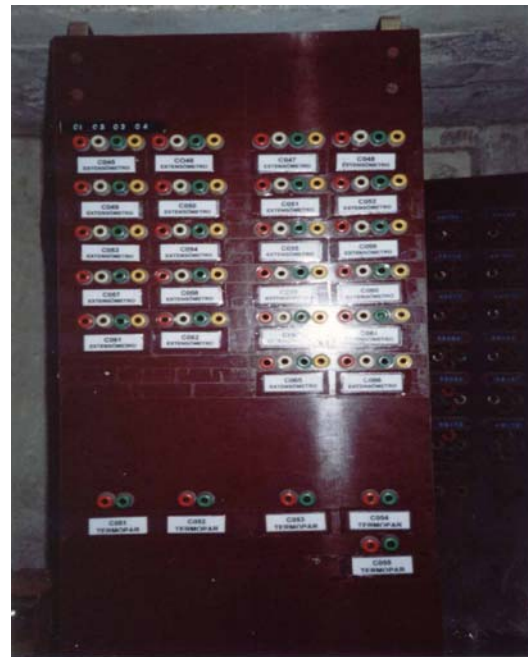
Figura 4.3 Quadro de controle dos extensômetros e do termômetro.
