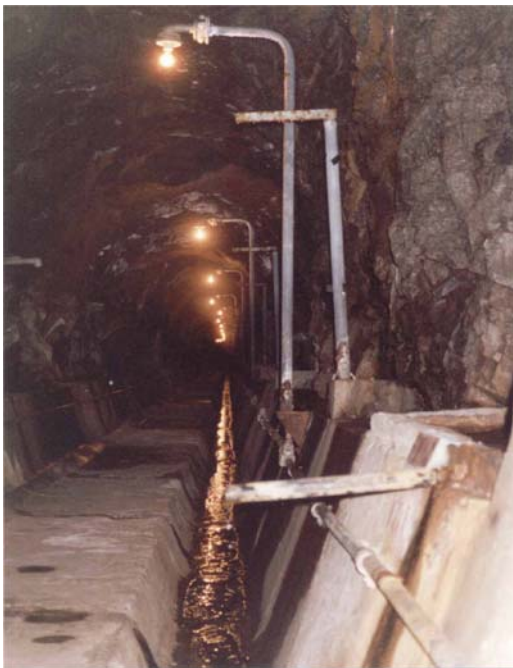
Figura 4.2 Galeria no soco da barragem de Funil.
