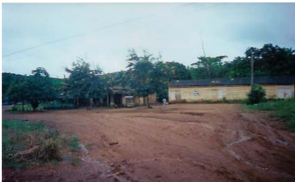
Foto 7 Prédio original do INCRA/ Escritórios desta Instituição e da ARCAPARÁ, 1973. Residência para Técnicos Agrícolas/Assistentes Sociais. Km. 200 do trecho ATM/ITB.
