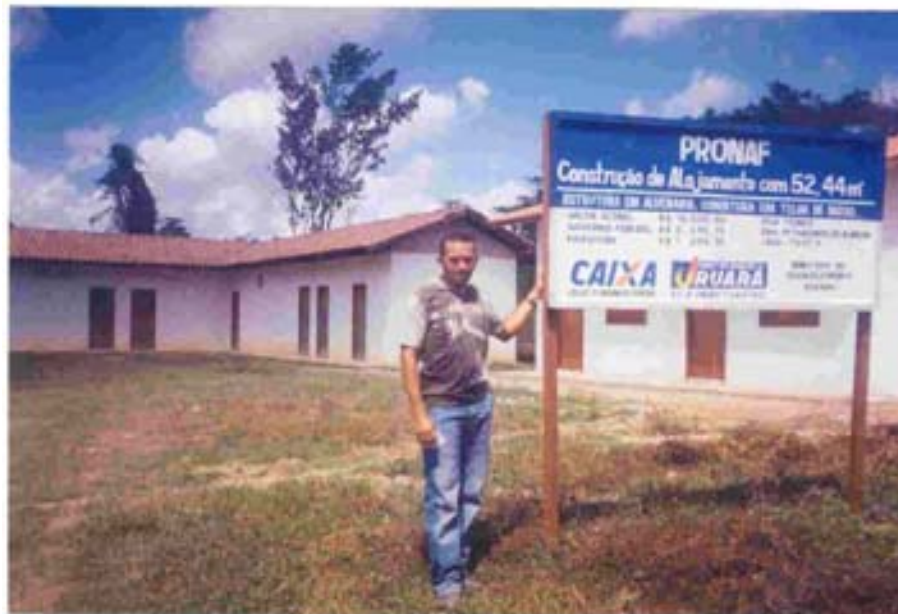
Foto 12 – Alojamento da Casa Familiar de Uruará antes da atual Reforma/Monitor Damião Silva.
