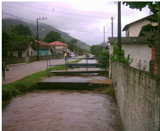
FIGURA 15 - Rua José Correia (Rua do Juca) em enchente de 2006. Este canal é o rio Ribeirão do Porto canalizado e que recebe esgoto residencial. Foto: Lizandro Machado.
