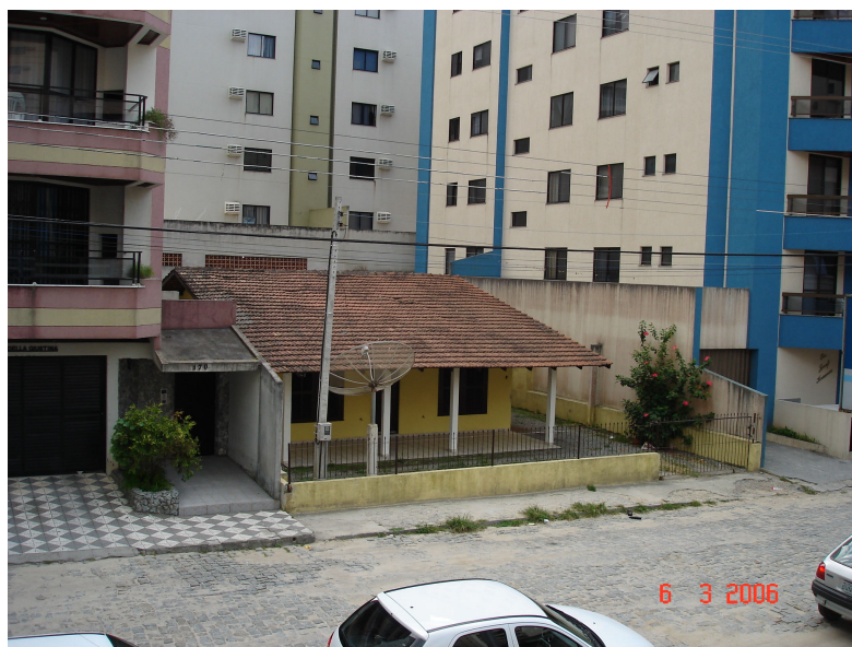
Figura 20 – Este imóvel (segundo seu morador) perdeu valor de mercado. Apresenta problemas com a umidade, além de não ser de interesse dos prédios que o circundam.
