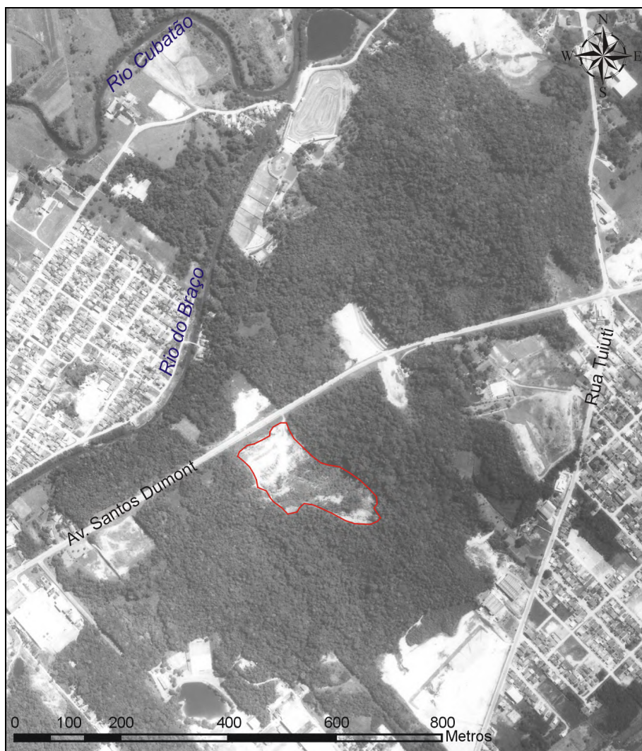
Figura 46 – Aerofoto com destaque para a cicatriz de movimento de massa rotacional no morro do Iririú, município de Joinville.
