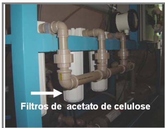
Figura 3.5: Módulo dos cartuchos de acetato de celulose de 5 \mu m
