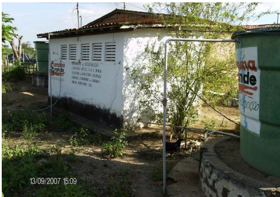
Figura 3.9: Abrigo do dessalinizador
