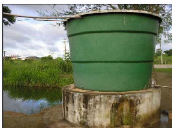
Figura 3.3: Tanque de água potável ou chafariz
