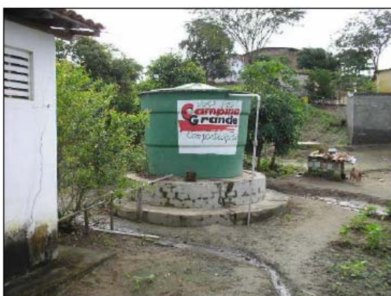
Figura 3.2: Tanque da água de alimentação
