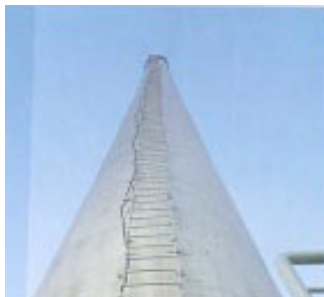
Figura 2.5 – Reforço de chaminé com sistema de fio de fibra de carbono sob tensão (Karbhari, 1998).
