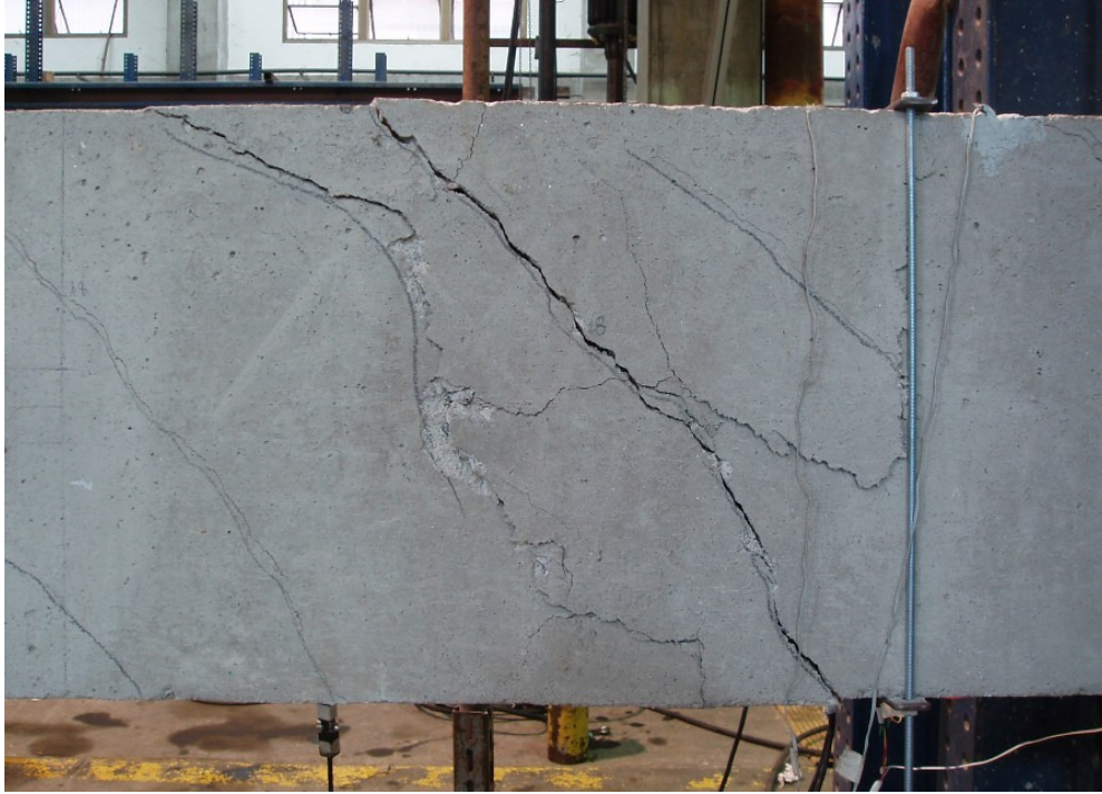
Figura B.8 – Detalhe da ruptura da viga VRef vista da face esquerda.
