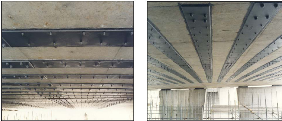
Figura 1.1 – Reforço estrutural por meio de colagem de chapa de aço com resina epóxi (Disponível em http://www.balvac.co.uk/upload/news ).
