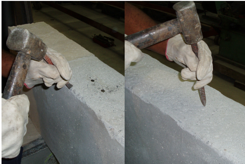
Figura 7.32 – Corte das quinas e apicoamento da superfície irregular.
