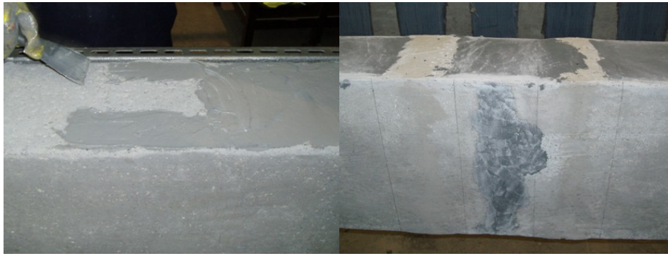
Figura 7.34 – Aplicação e regularização da superfície superior com Sikadur 30.
