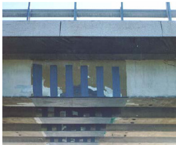
Figura 2.7 – Reforço de ponte à força cortante com CFC.
