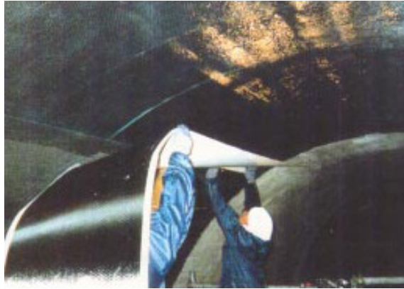
Figura 2.6 – Reparo de túnel com CFC (Karbhari, 1998).
