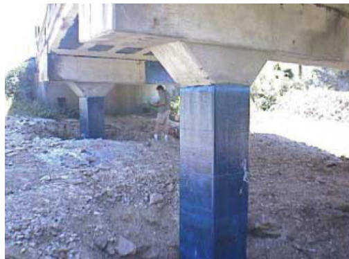
Figura 2.4 – Confinamento de pilares com CFC.
