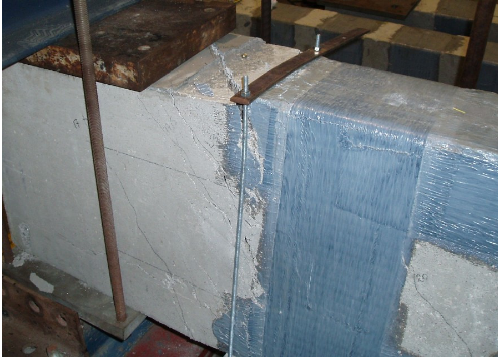
Figura B.36 – Detalhe da ruptura da viga VTL1 vista da esquerda.
