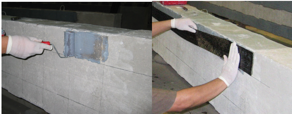
Figura 7.35 – Aplicação do sistema de reforço com CFC.
