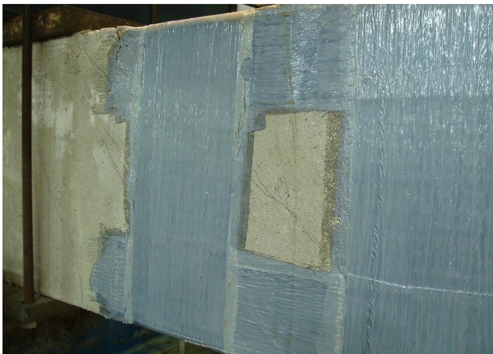
Figura B.49 – Detalhe da ruptura da viga VTL3 vista da direita.
