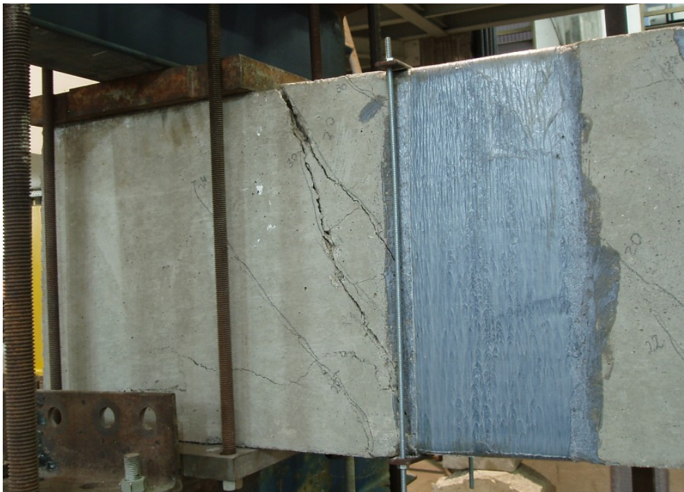
Figura B.23 – Detalhe da ruptura da viga VT2 vista da esquerda.
