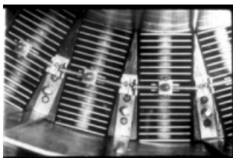
Figura 2.5 - Visão superior de elementos combustíveis inseridos no núcleo do reator.
