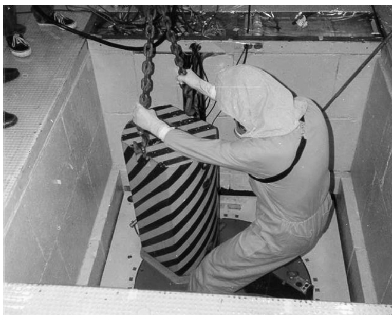
Figura 2.7 - Troca de elemento combustível no reator Argonauta.
