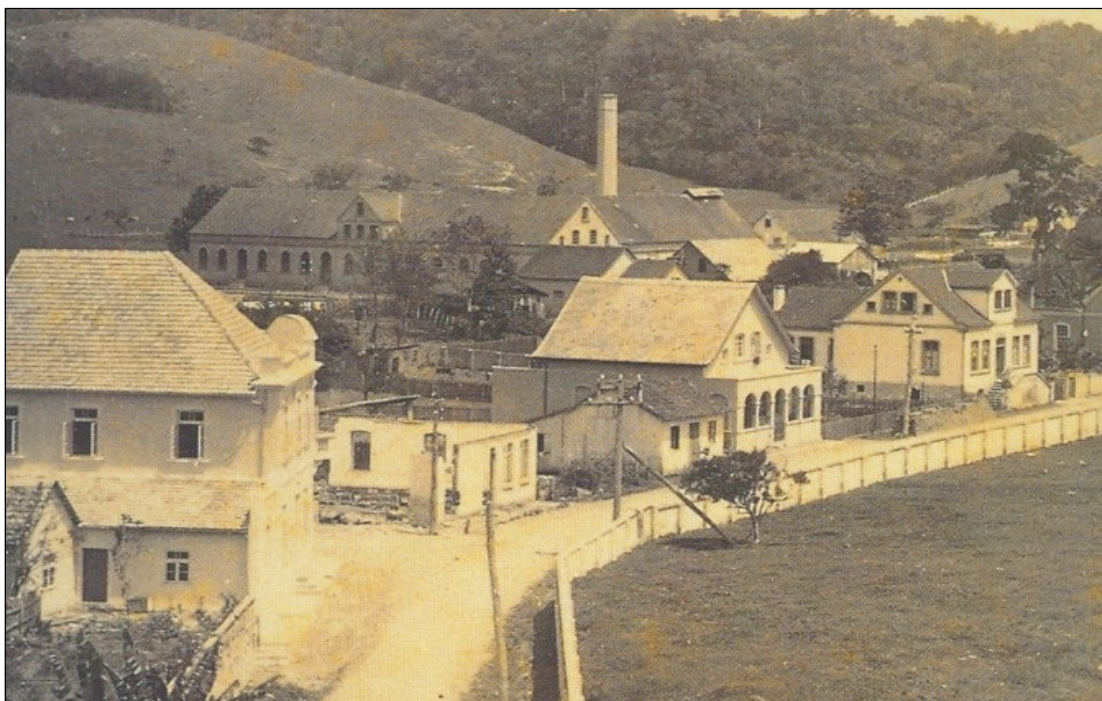
Figura 10 – Vista panorâmica da entrada da cidade, na década de 40. Pode-se observar a casa comercial de José Elias Soar (esquina), os prédios de propriedade de Maria Cândida Höschl e a usina de açúcar e álcool de Fontes & Cia. Fonte: Arquivo Histórico José Ferreira da Silva, 1997.
