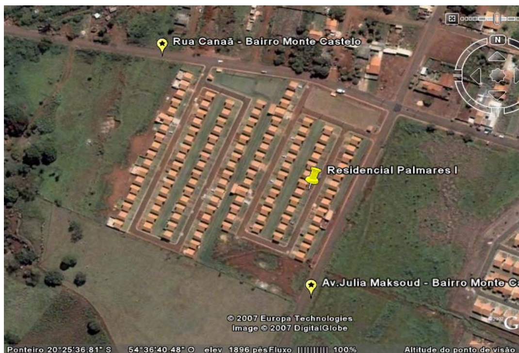
Figura 03 - Vista aérea do Condomínio Residencial Palmares
