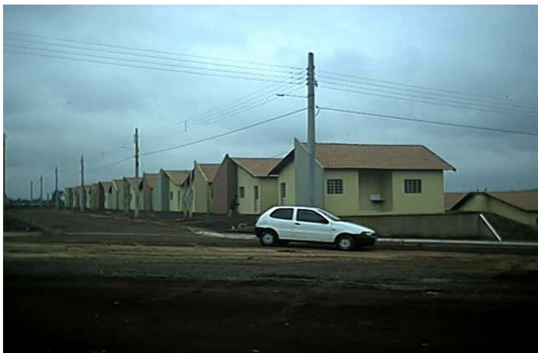
Figura 5 - Fase terminal de entrega da obra do Condomínio.
