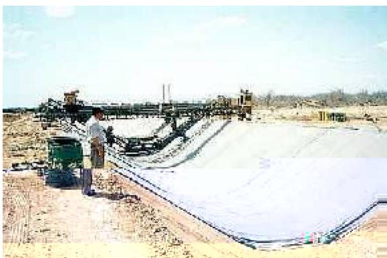
Figura 17: Geomembrana já totalmente colocada.
