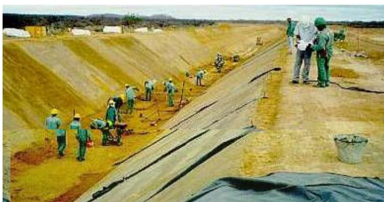
Figura 16: Geomembranas sendo colocadas em grande extensão de vala.
