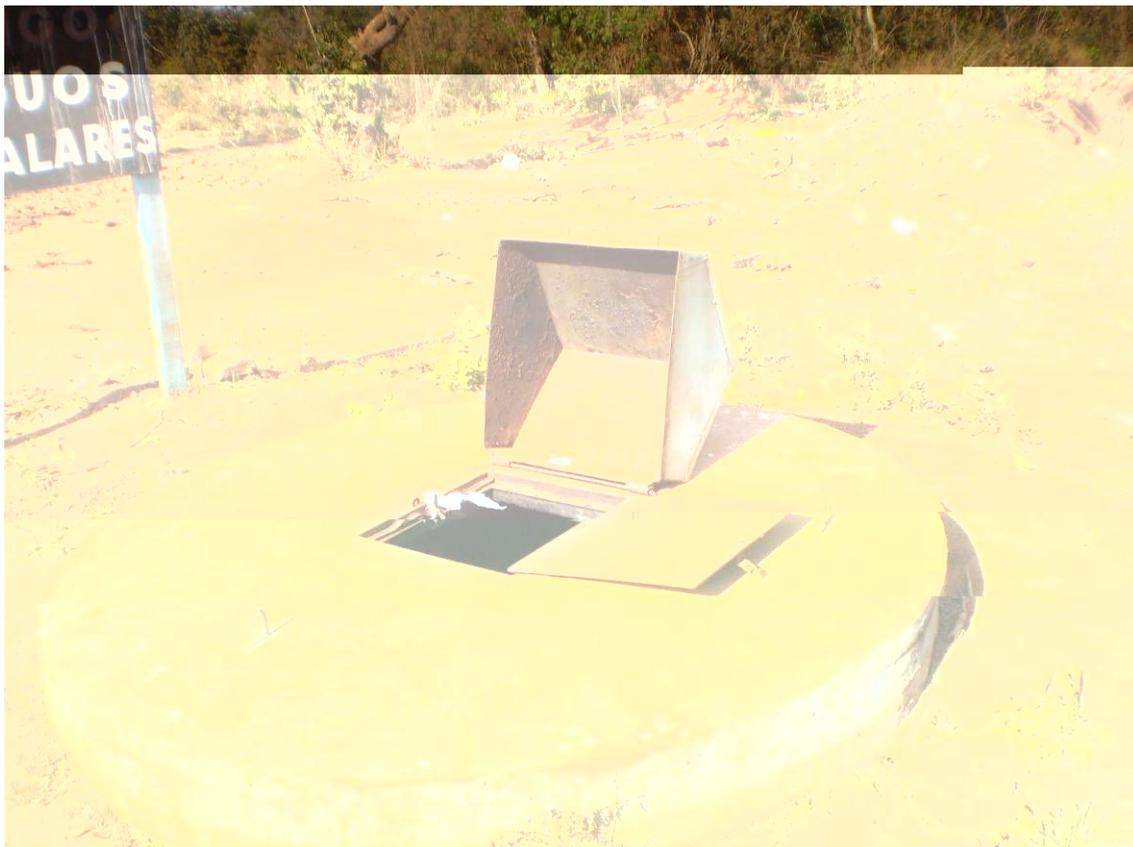
Figura 40: Vala séptica para RSSS aberta e fumegando no aterro controlado de Tupaciguara.
