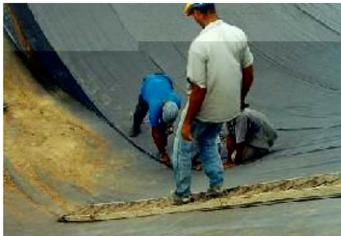
Figura 15: Geomembrana sendo colocada.
