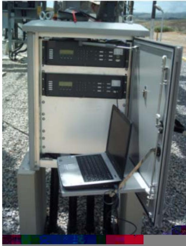
Figura II.6 - Parametrização em um relé digital instalado no campo
