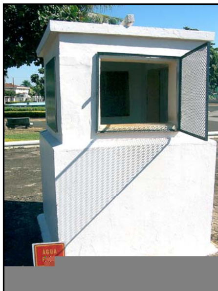
Figura 14. Reservatório 2 (água potável)
