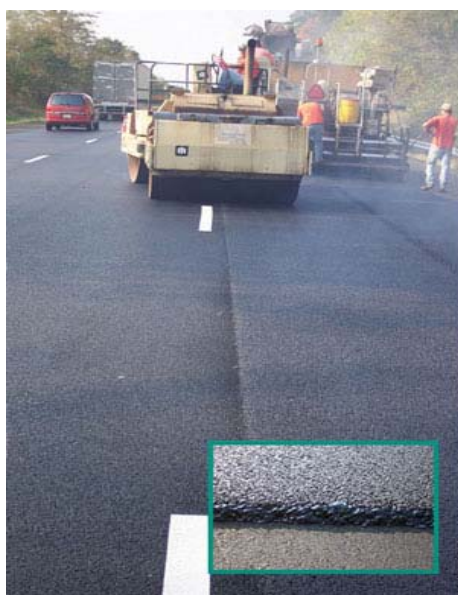
Figura 2.6: Aplicação de camada de SMA em rodovia de Maryland – EUA
