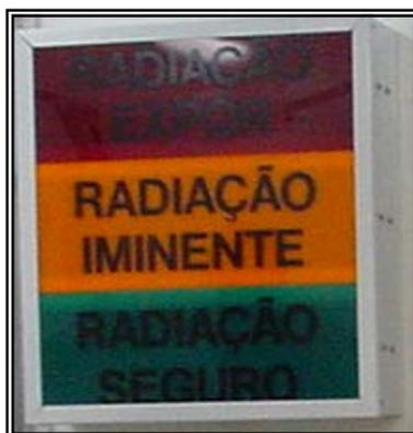
Figura 4.2 – Indicador do nível de radiação da sala de controle.
