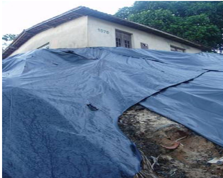
Figura 14 – Proteção da encosta com lona
