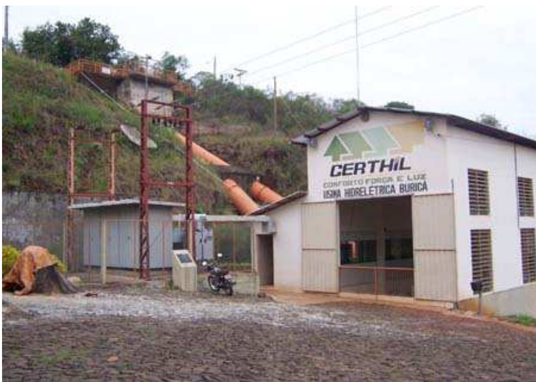
Figura 6 Vista frontal da Casa de Máquinas da Usina Hidrelétrica Buricá
