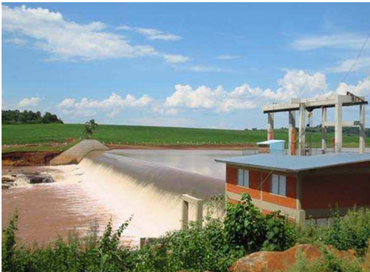
Figura 4 – Visão lateral da Usina José Barasuol
