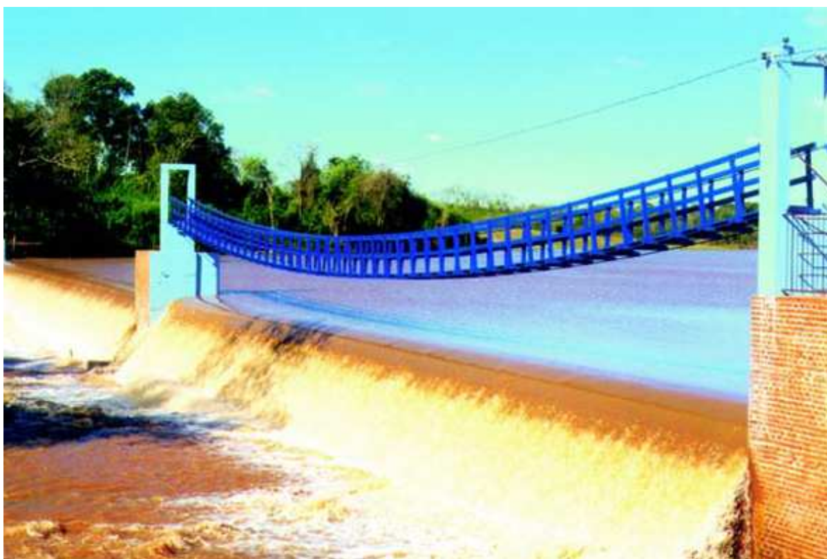
Figura 3 – Usina Hidrelétrica Nilo Bonfanti – Visão lateral
