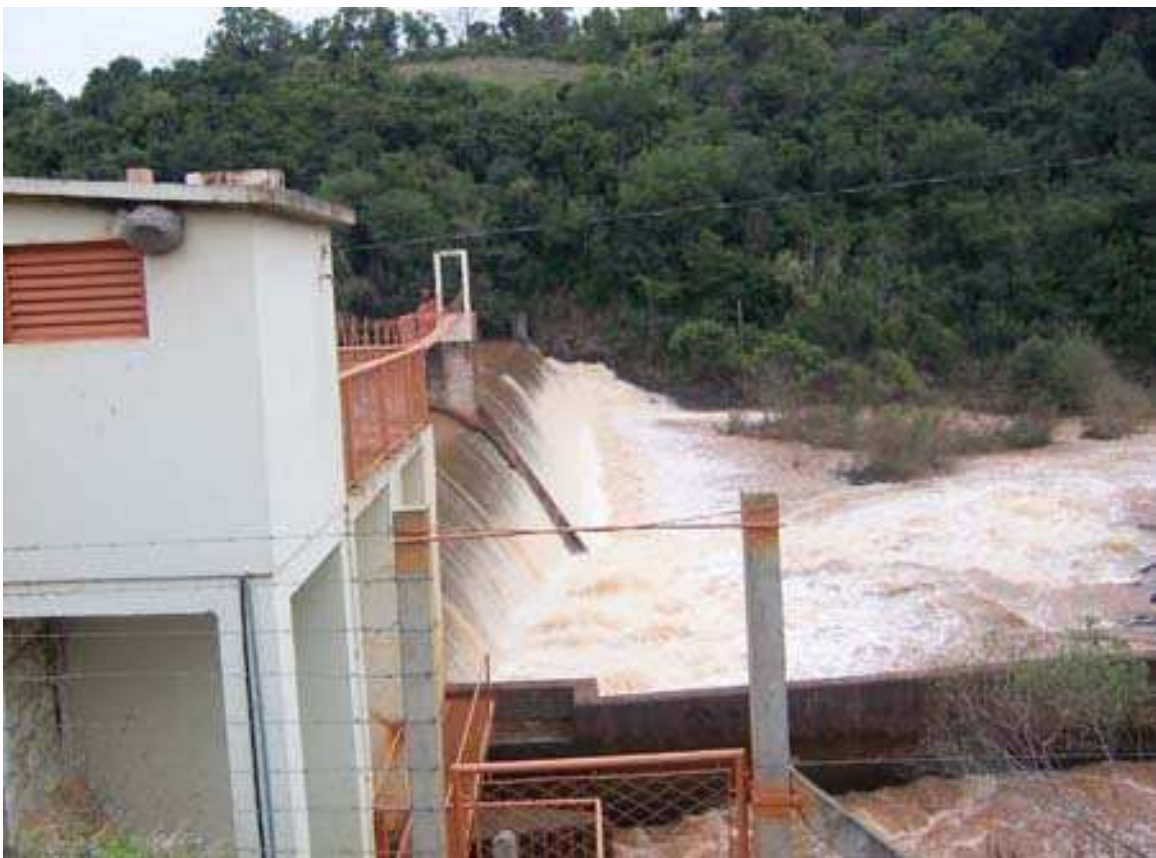
Figura 7- Visão lateral do vertedouro da barragem da PCH do rio Buricá
