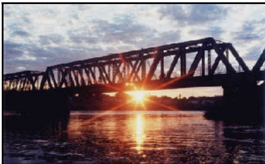
Figura 5: Ponte Marechal Hermes Fonte: Foto Caravelas - 2006.
