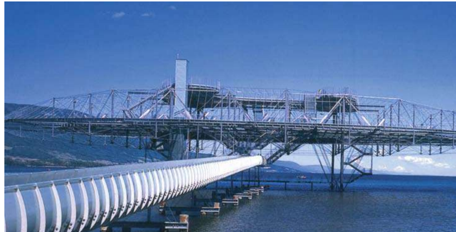
► Blur Building, Elizabeth Diller e Ricardo Scofidio, 2000-2002, Yverdon-les-Bains, Suíça. O pavilhão possui como vedação uma nuvem obtida através do uso de água do lago filtrada expelida como um nevoeiro pouco espesso por meio de 31500 dispersores de água de alta pressão. [JODIDIO, 2004, p. 172]
