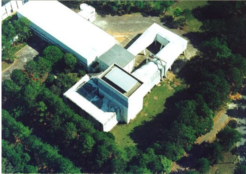
Figura 2.1 - Instalações do túnel de vento – TA-2 do CTA (IAE, 2005).
