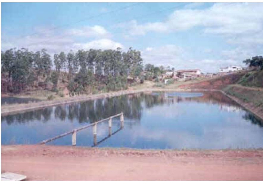
Figura 10 – Lagoa de estabilização (Fonte: http://www.etg.ufmg.br/tim2/tratamento2.ppt – 17/03/2007)
