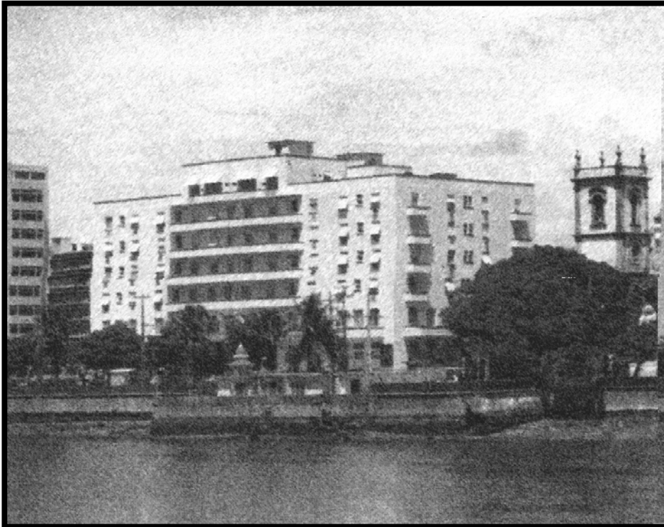
Figura 12: Vista Diurna do Grande Hotel do Recife
