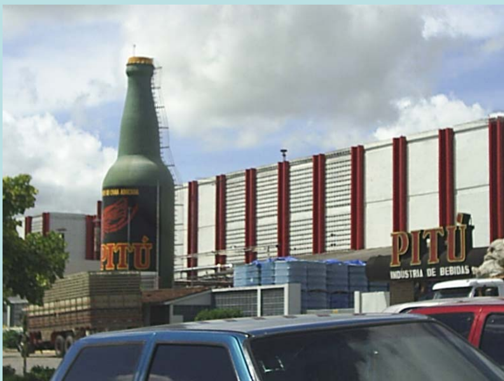
As mesmas instalações atualmente. Foto: Maria Rita Machado.
