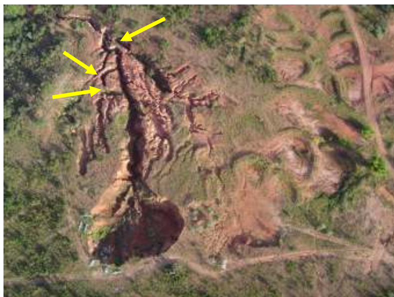
Fig. 41 – Rede de canais responsável pelo fornecimento de energia e matéria para o canal principal. As setas indicam os principais fornecedores (ALVES – Junho de 2004).
