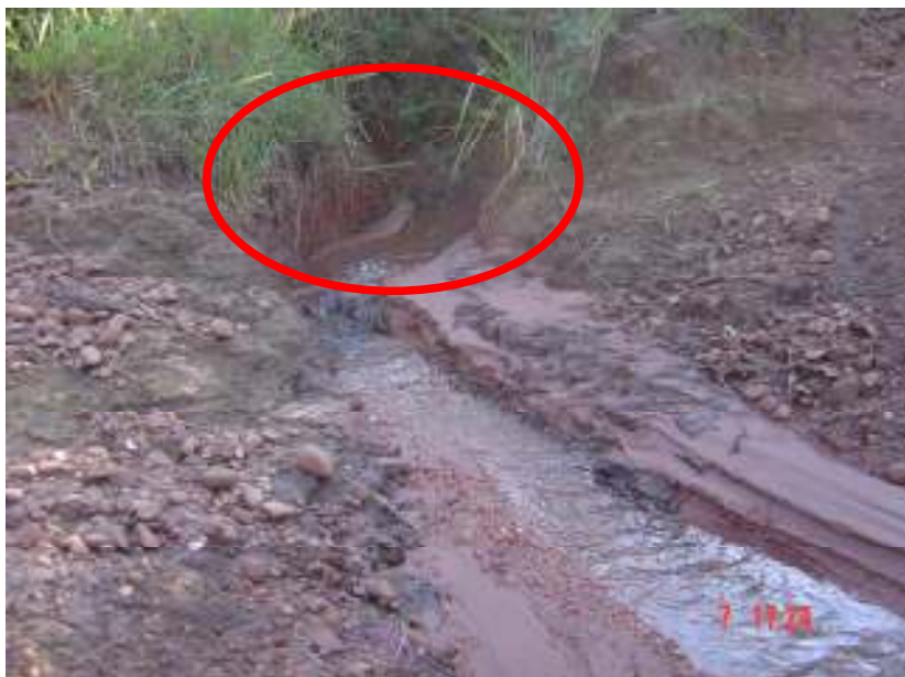
Fig. 4 – A área destacada pelo círculo vermelho representa onde foi construído o vertedouro para medição de vazão (ALVES – Abril de 2004).
