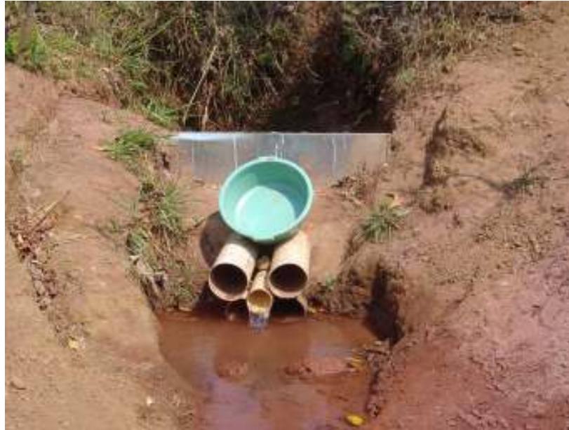
Fig. 6 – Esta figura mostra a bacia plástica utilizada no procedimento de medição de vazão (ALVES – Setembro de 2004).
