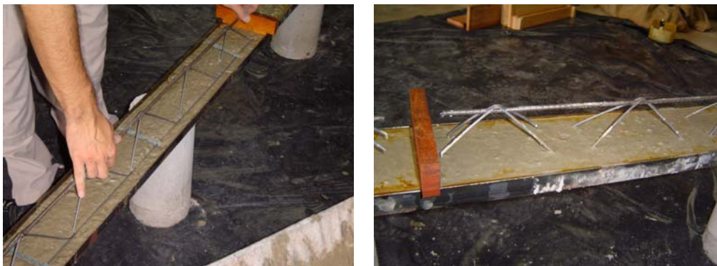
Figura 22: Moldagem das vigotas pré-moldadas treliçadas
