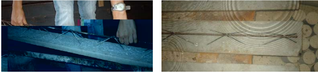
Figura 23: Processos de desmoldagem e cura das vigotas pré-moldadas treliçadas
