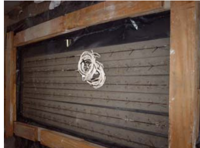
Figura 28: Vigota pré-moldada após 24 horas da moldagem e sua cura
