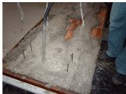
Lançamento e adensamento do concreto
