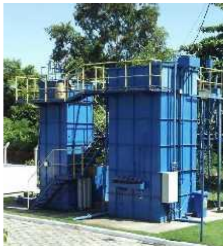
Figura 4.1: Vista geral da Estação de Tratamento de Esgoto ã ETE UFES
