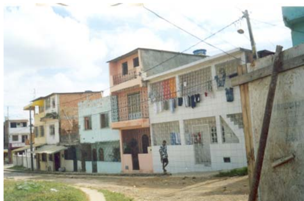
Lobato - Rua com ausência de calçamento. Foto: Imaira Regis, 2006.
