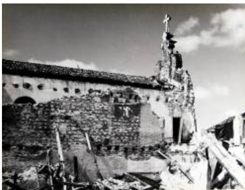
Figura 10. Prosseguimento da demolição de edificações vizinhas. Detalhe para as escoras utilizadas para que a fachada não pendesse para o lado que estava sendo removido Fonte: IPHAN/ 5º SR
