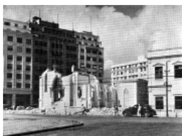
Figura 9. Destruição Igreja do Paraíso, 1944 Fonte: Museu da Cidade do Recife
