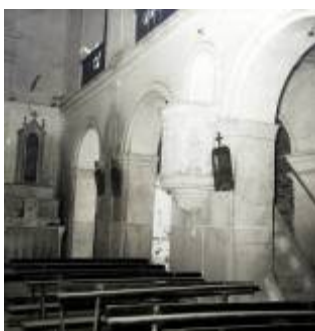
Figura 14. Bancos na nave central Fonte: IPHAN/ 5ºSR
