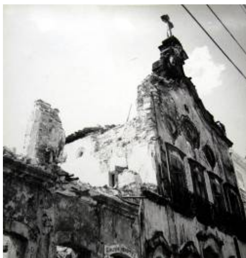
Figura 9. Igreja dos Martírios com sobrado ao lado esquerdo ruído pelo seu primeiro pavimento que veio abaixo Fonte: IPHAN/ 5° SR
