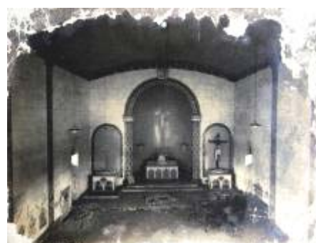
Figura 6. Nave principal da Igreja do Paraíso com altar ao fundo Fonte: IPHAN/ 5º SR
