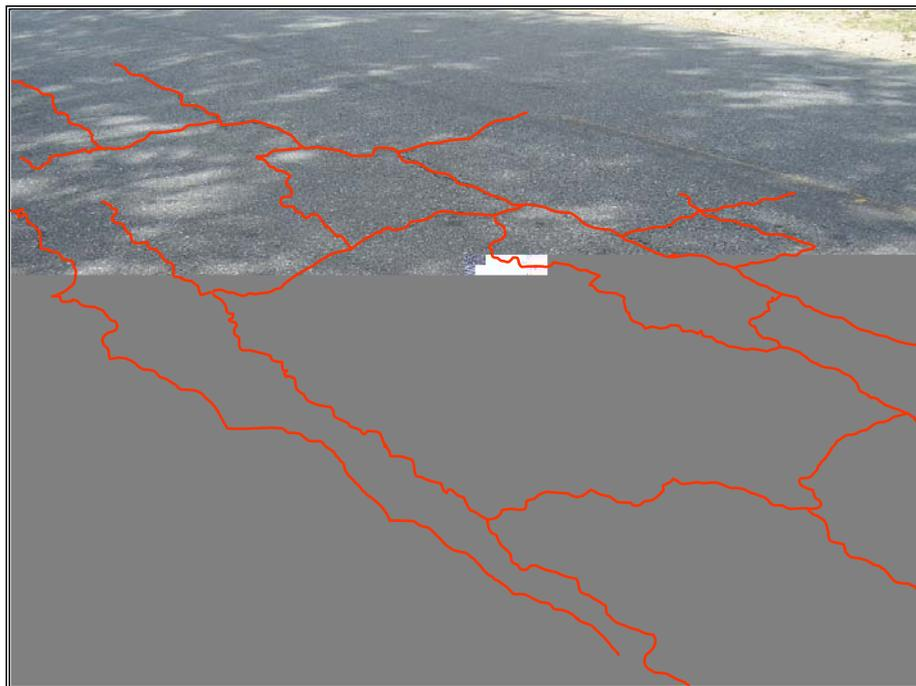
Figura 49: Trincamento de bloco, não associado às cargas de tráfego, no km 1+600 da PB-079 (revestimento em CBUQ).
