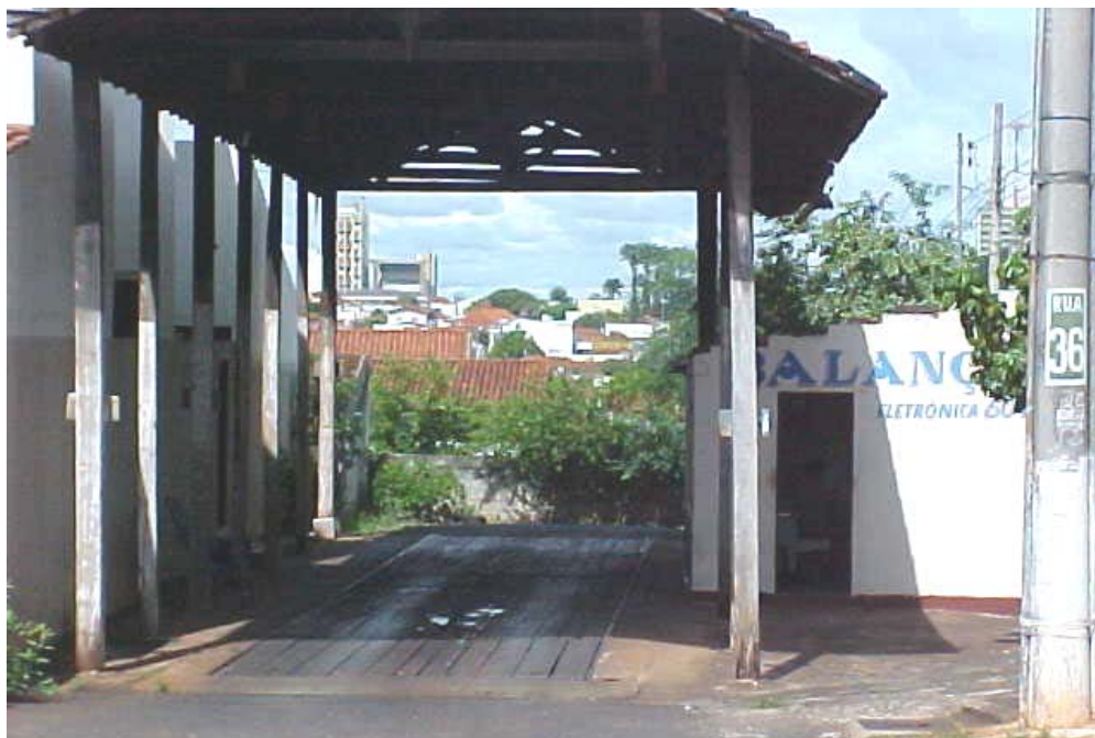
Figura 37. Foto da Balança onde ocorre a pesagem dos resíduos, junho/2005.
