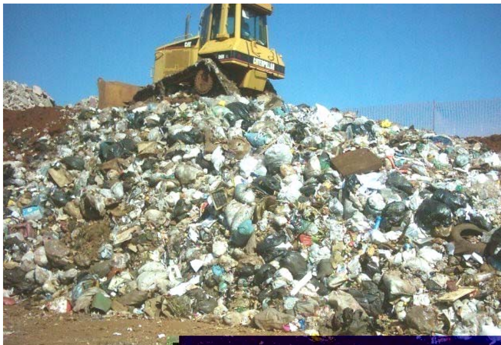
Figura 32. Compactação de resíduos secos e recicláveis no aterro municipal, junho/2006.
