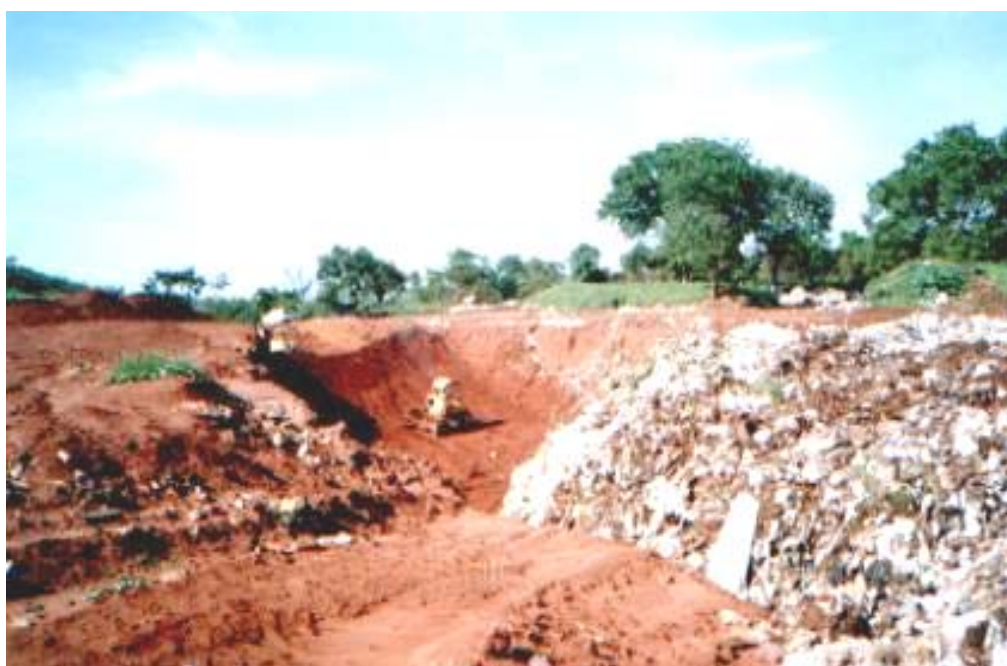
Figura 5. Antigo local destinado ao Lixão, em Ituiutaba (MG), fevereiro/2001.
