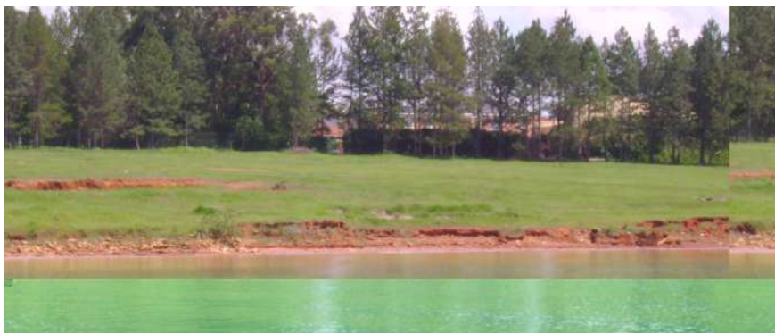
Figura 104: Alguns processos erosivos no Parque do Anfiteatro Natural do Lago Sul Fonte: Foto do autor (2007).
