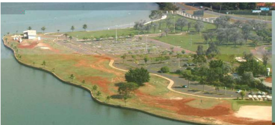
Figura 99: Pontão do Lago Sul, área com erosão e solo exposto Fonte: Seduma (2005).
