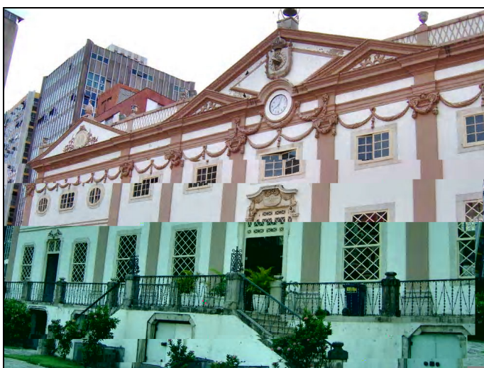
Figura 4.35 – Sede da Associação Comercial da Bahia. Foto da autora – abr. 2006.
