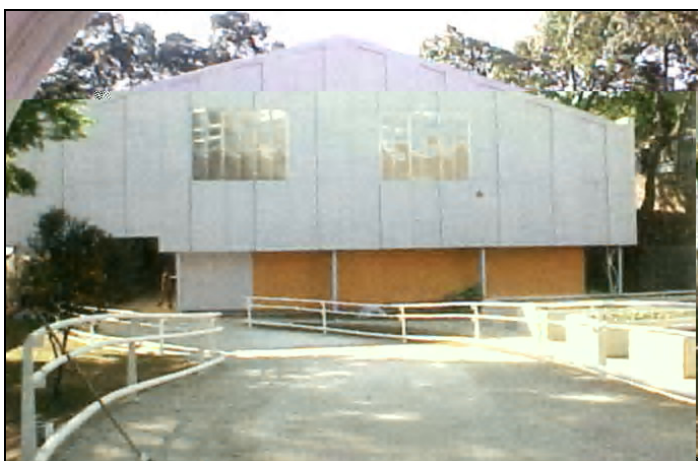
Figura 2.30 – Galpão da Oficina Boracéia. Fonte: São Paulo, 2004.
