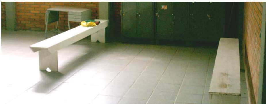
Figura 10: Vestiário do Prédio da ACM Restinga Olímpica
