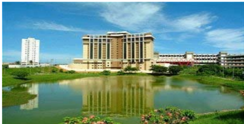
Figura 31: Hotel Holiday Inn, em frente ao Centro de Convenções da Bahia, 2006
