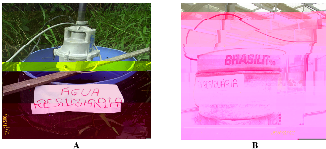
Figura 4 - Poço para recalque da água de esgoto e bomba submersa (A) e reservatório de armazenamento (B). Campina Grande – PB, 2006
