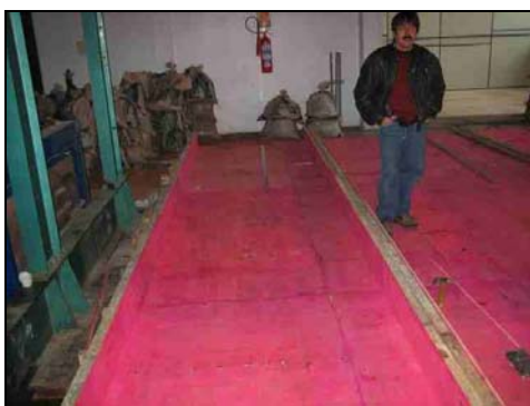
FOTO 3.10: EXECUÇÃO DAS FORMAS
