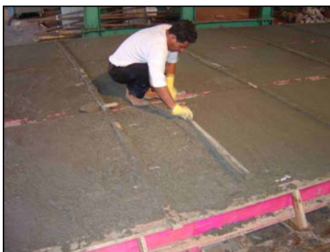
FOTO 3.33: CONCRETAGEM DAS LAJES
