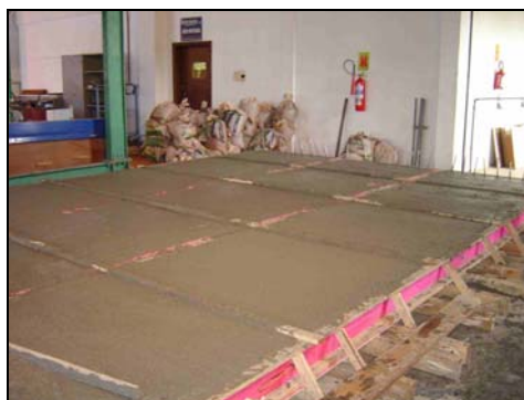
FOTO 3.34: CONCRETAGEM DAS LAJES
