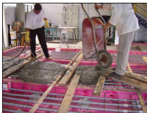
FOTO 3.30: CONCRETAGEM DAS LAJES
