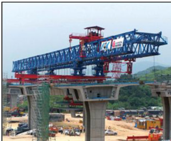
FOTO 2.1: ADUELAS PRÉ-MOLDADAS DO TABULEIRO DE UMA PONTE NA ÁSIA FONTE: VSL International, 2006
