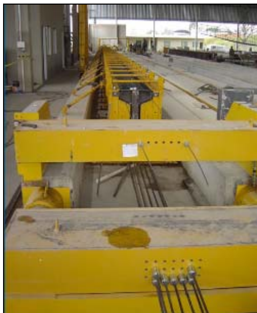
FOTO 2.2: PISTA DE VIGAS TIPO “I” DE UMA INDÚSTRIA DE PRÉ-FABRICADO FONTE: Weiler C. Holzberger Industrial Ltda, 2006
