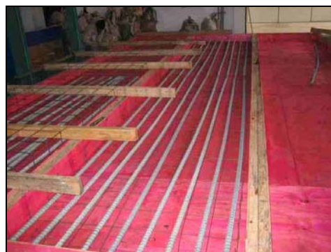
FOTO 3.19: ARMAÇÃO DAS LAJES
