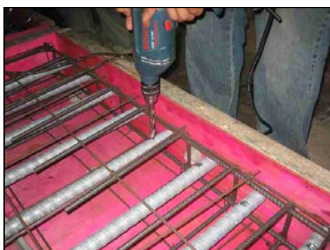
FOTO 3.26: COLOCAÇÃO DE PURGADORES
