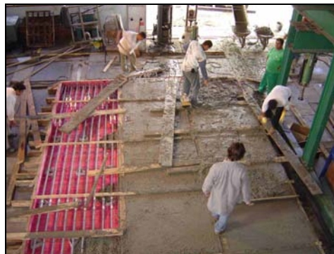
FOTO 3.32: CONCRETAGEM DAS LAJES
