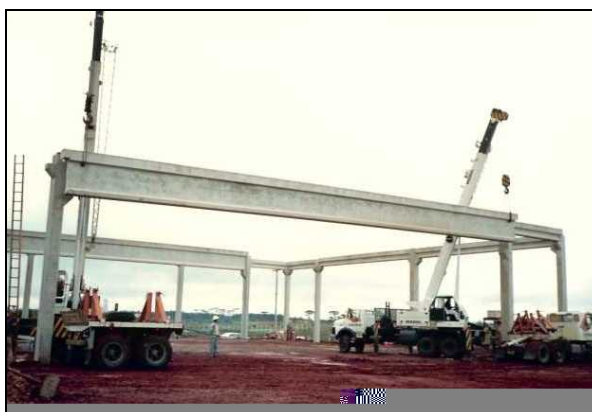
FOTO 2.5: ELEMENTOS PRÉ-FABRICADOS FONTE: Consid, 1994
