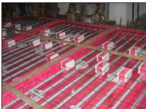
FOTO 3.20: ARMAÇÃO DAS LAJES
