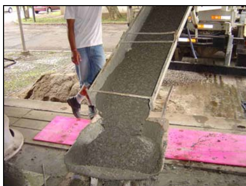
FOTOS 3.29: CONCRETAGEM DAS LAJES
