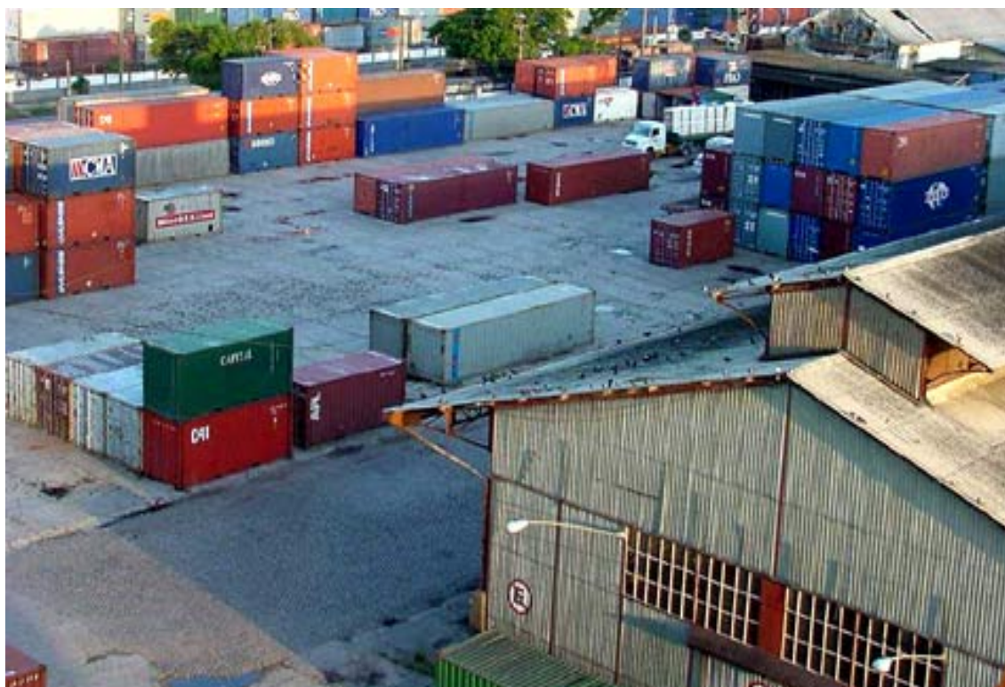
FIGURA 7: Porto de Belém do Pará- Pátio de armazenamento de Contêineres e Cargas.
