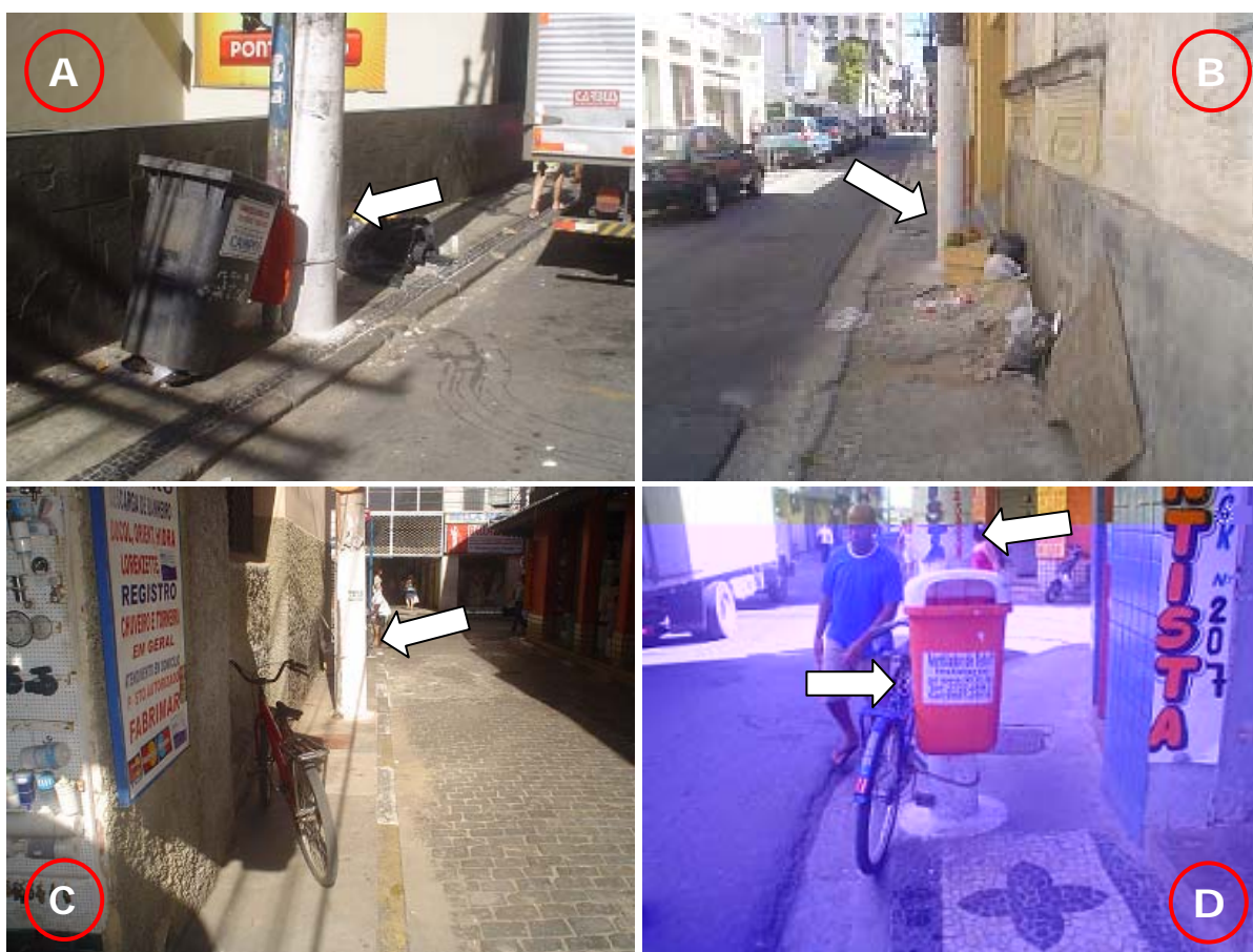
Figura 12 – Seqüência de postes instalados no meio das calçadas no centro da cidade. Foto “A”: rua 21 de abril, foto “B”: rua Carlos de Lacerda, foto “C”: travessa Carlos Gomes e foto “D”: rua Santos Dumont.
