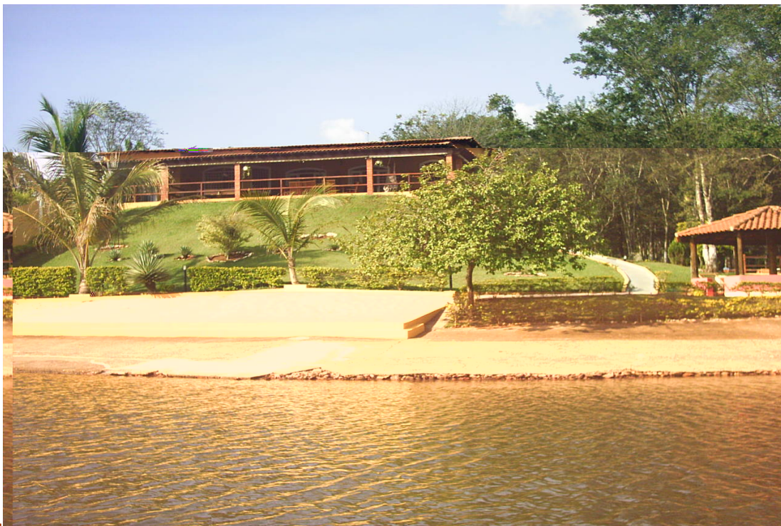
FIGURA 22 - Edificação às margens do Lago de Miranda. FONTE: BORGES, Adairlei A. da Silva, 2006.
