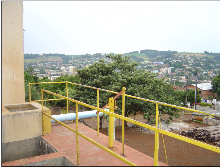
Figura 42: Parte da cidade de Coronel Vivida, observada da ETA. No canto inferior esquerdo, tubulação de chegada de água do Rio Barro Preto. Na parte central da foto observa-se parte da cidade de Coronel Vivida. (Foto da autora 15/05/2005).
