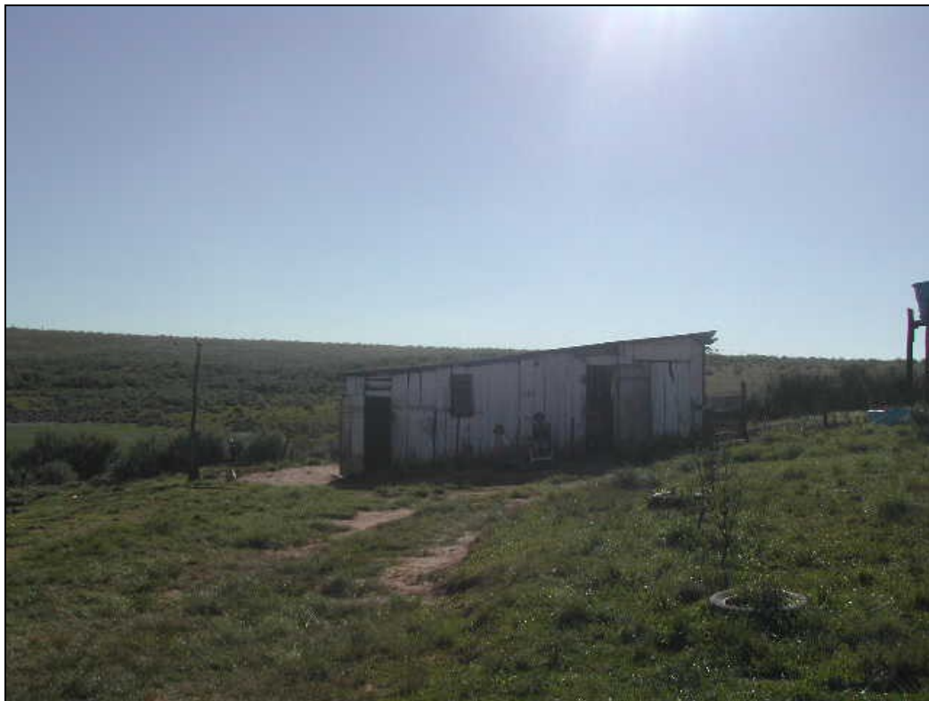
Fotografia 17 – Casa em precárias condições de moradia no assentamento Alvorada. Fonte: Trabalho de campo realizado nos meses de Agosto/Setembro de 2007.
