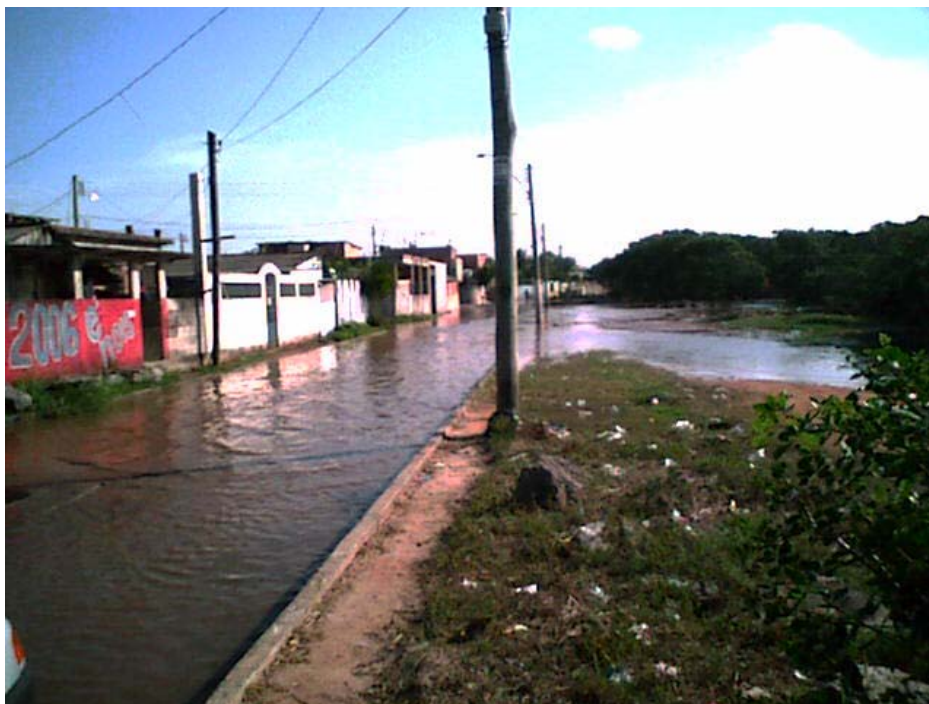
Figura 54. Alagamento observado no Bairro Inhanguetá (esquerda), limítrofe à área de manguezal (direita), na zona Oeste de Vitória, no dia 19/03/2007. Perspectivas em direção a Oeste, com ponto de descarga da galeria ao fundo.
