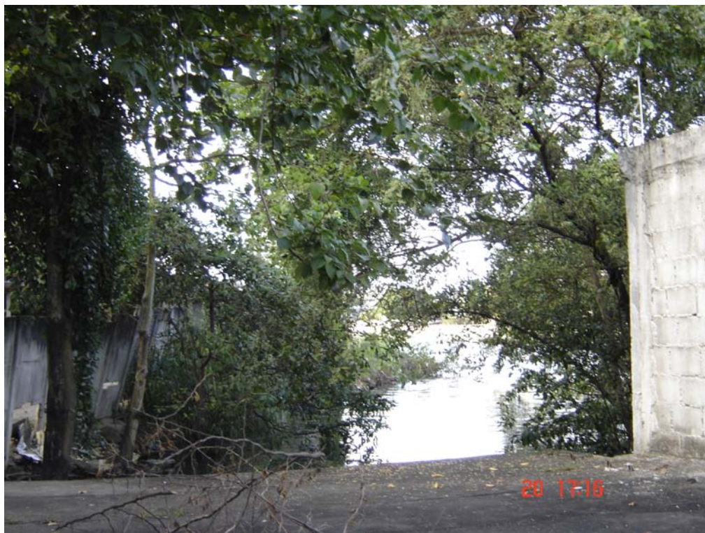
Figura 32. (a) Localização e (b) vista in situ do ponto de descarga, no Canal da Passagem, da galeria de drenagem do Bairro Barro Vermelho, zona Norte da Ilha de Vitória.
