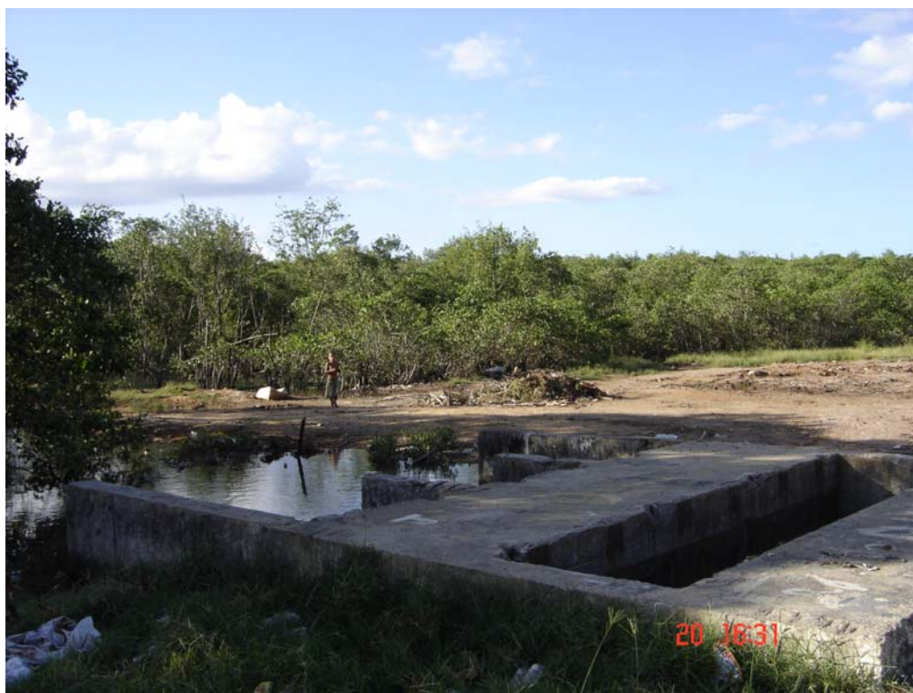
Figura 28. (a) Localização e (b) vista in situ do ponto de descarga da galeria de drenagem da Rua da Galeria, no Bairro Inhanguetá, zona Oeste da Ilha de Vitória.
