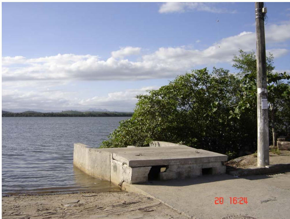
Figura 30. (a) Localização e (b) vista in situ do ponto de descarga da galeria de drenagem da Rua da Galeria, no Bairro Grande Vitória, zona Oeste da Ilha de Vitória.
