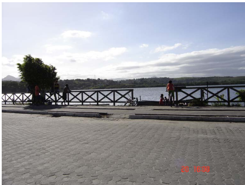
Figura 24. (a) Localização e (b) vista in situ do ponto de descarga da galeria de drenagem da Rua Aderbal Athaide Guimarães, no Bairro Bela Vista, zona Oeste da Ilha de Vitória.
