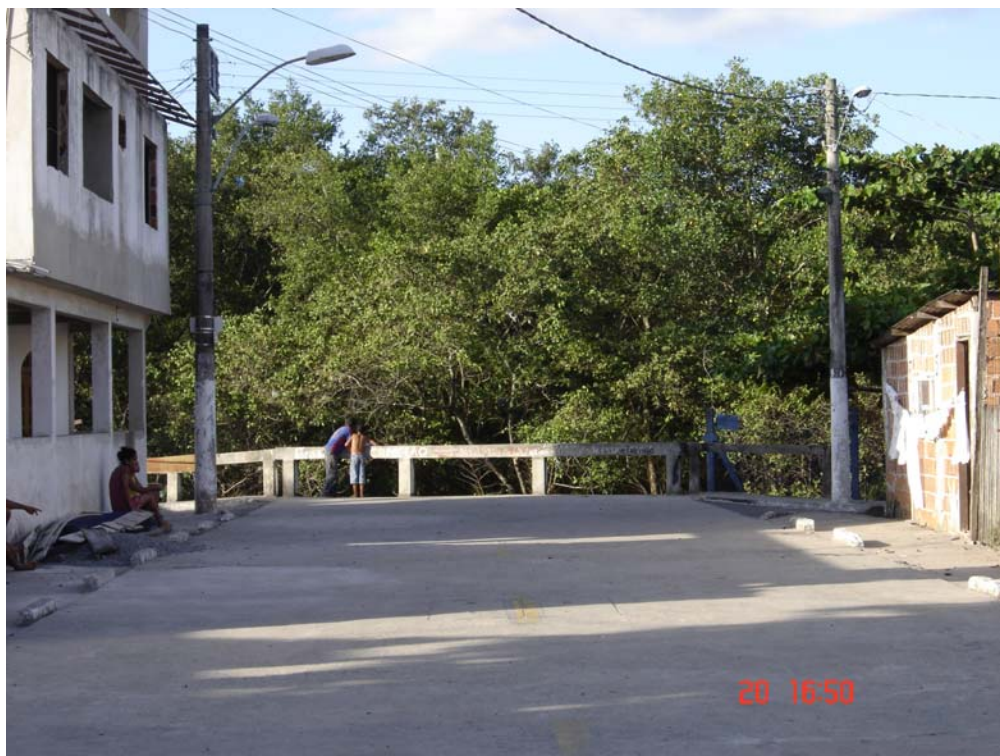
Figura 26. (a) Localização e (b) vista in situ do ponto de descarga da galeria de drenagem da Rua Wilson Toledo, no Bairro Santo André, zona Oeste da Ilha de Vitória.
